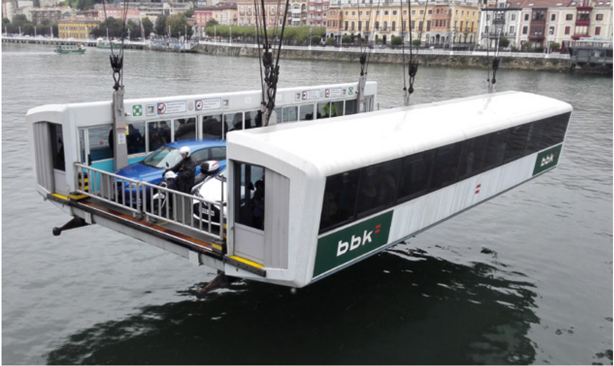
Bilbao, la piattaforma sospesa del Puente Colgante per il trasporto di mezzi e persone da una riva all'altra
