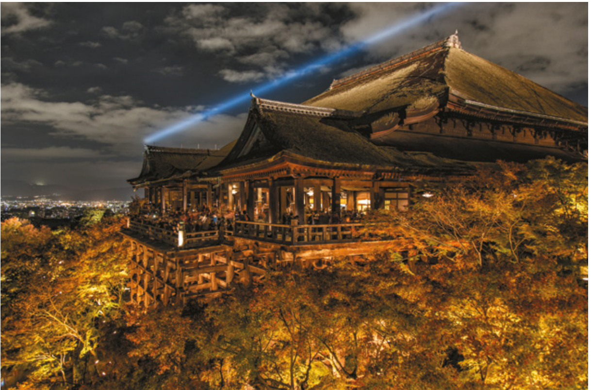
La terrazza sostenuta da 139 pilastri del Kiyomizu-dera
